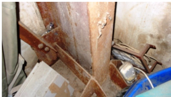
Εικ. 7: (α) Βάση υπ/τος με σημαντική οξείδωση και (β) τοιχείο πλινθοδομής με έντονη ρηγματώση.
