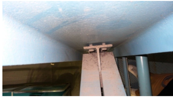
Εικ. 2: Σύνδεση με χαλαρή κοχλίωση.
