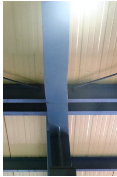
Εικ. 3: Ανεπαρκής σύνδεση δοκού-υπ/τος.
